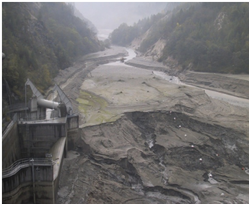
Lo svaso del bacino di Pontesei (prima e dopo le operazioni di fluitazione)
