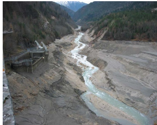
Lo svaso del bacino di Pontesei (prima e dopo le operazioni di fluitazione)
