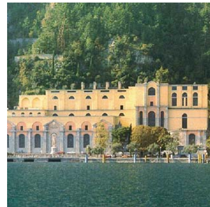
Centrale di Riva del Garda
