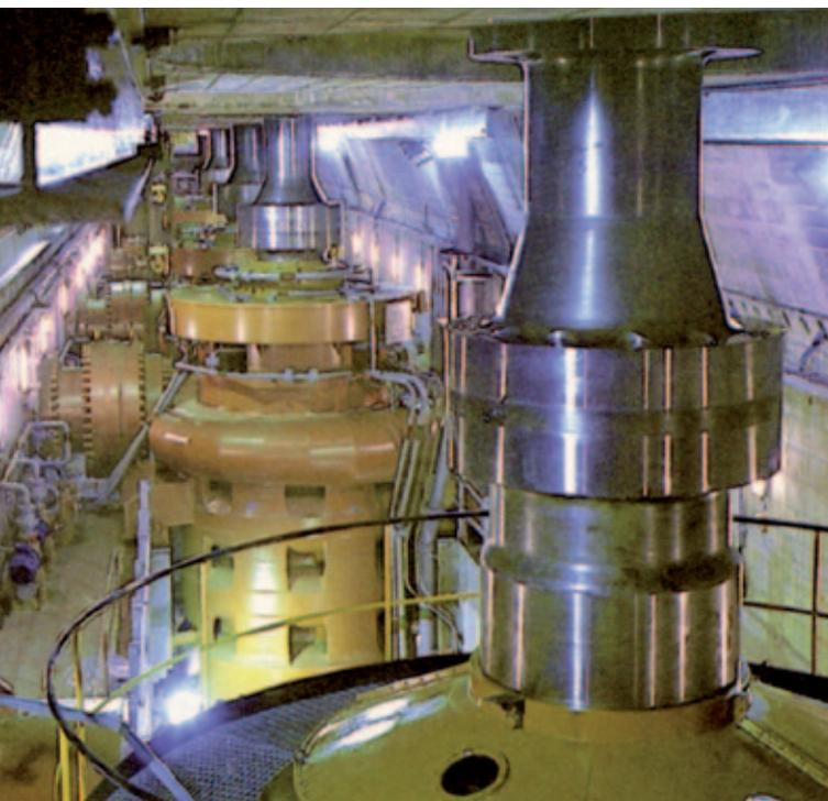
La pratica del pompaggio consente infatti di accumulare acqua nei bacini a monte in modo da poterla utilizzare successivamente per produrre energia elettrica mediante impianti caratterizzati dalla duplice funzione di produzio-
