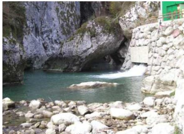
A valle di un rilascio costante d'acqua da un'opera di presa, la quantità d'acqua visibile in alveo dipende anche dalle infiltrazioni in sub-alveo dall'acqua proveniente dal bacino imbrifero residuo a valle dello sbarramento.
