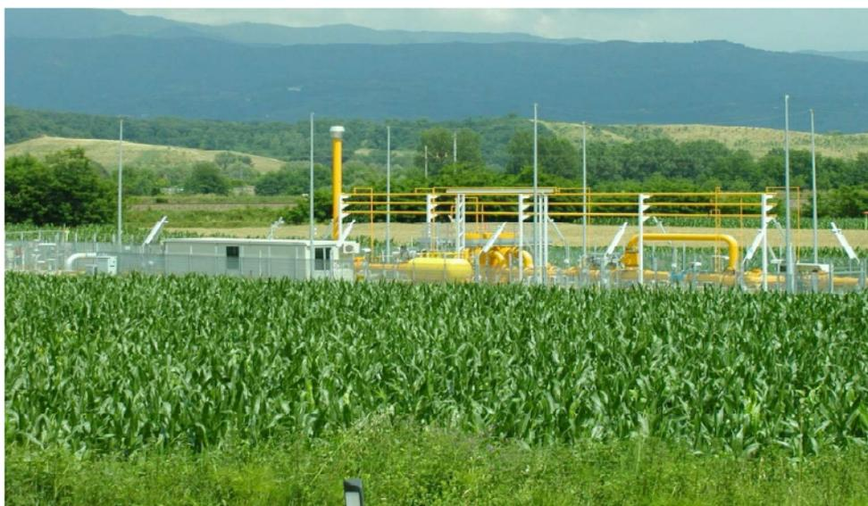
Dal punto di consegna il gas percorre un gasdotto di proprietà Enel della lunghezza di circa 5,8 km che termina presso l'impianto con la stazione di riduzione della pressione. Il gasdotto è completamente interrato e gran parte del suo percorso cade all'interno dell'area della
