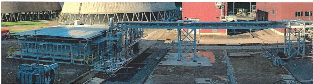
Figura 7 – Impianto TES di Santa Barbara
