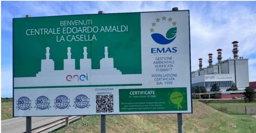
Cartello informativo lungo la strada di accesso alla centrale
