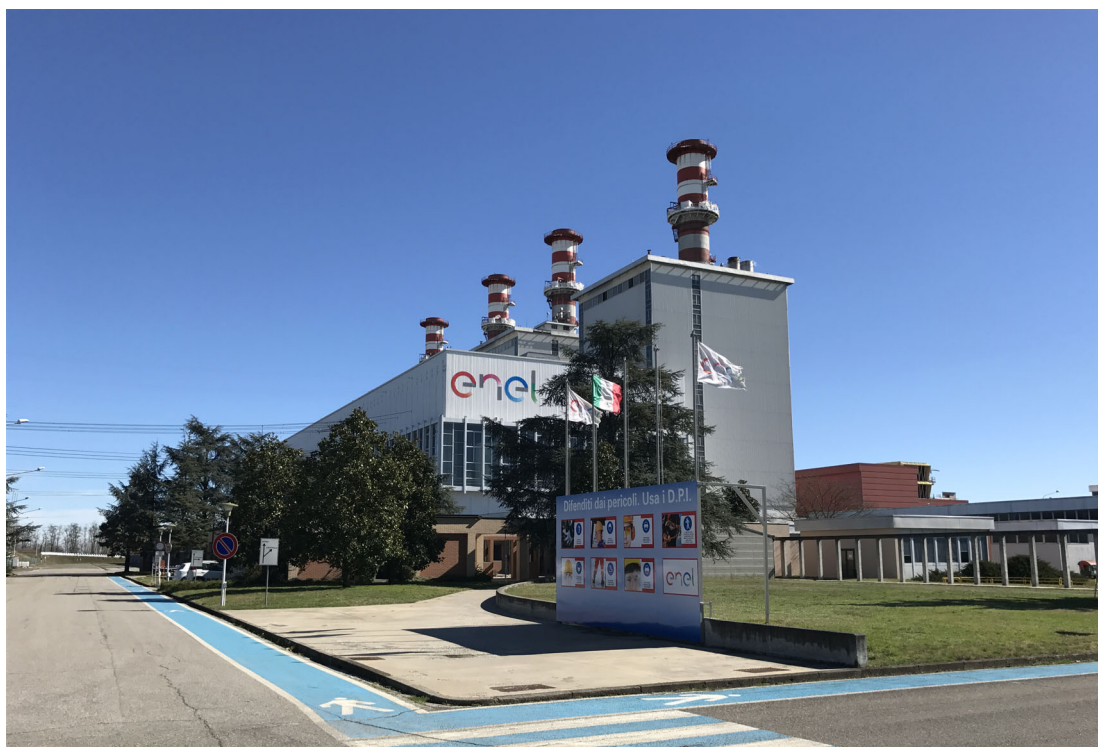
Figura 10 – Vista esterna dell’impianto di La Casella
