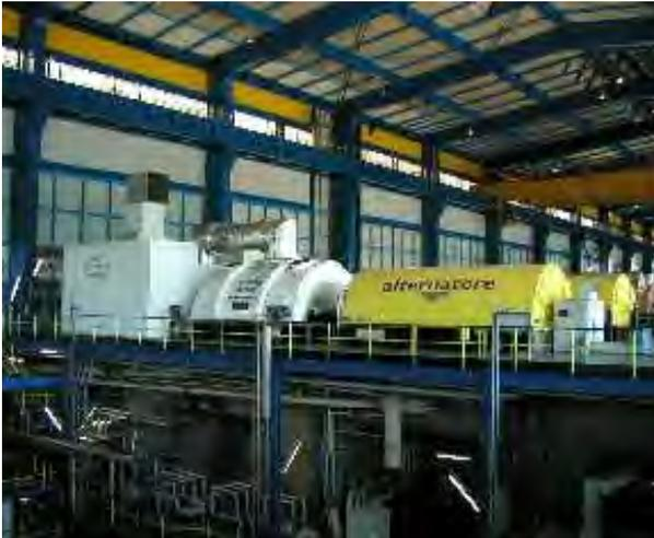
Figura 5: turbina a vapore e alternatore del ciclo combinato.
