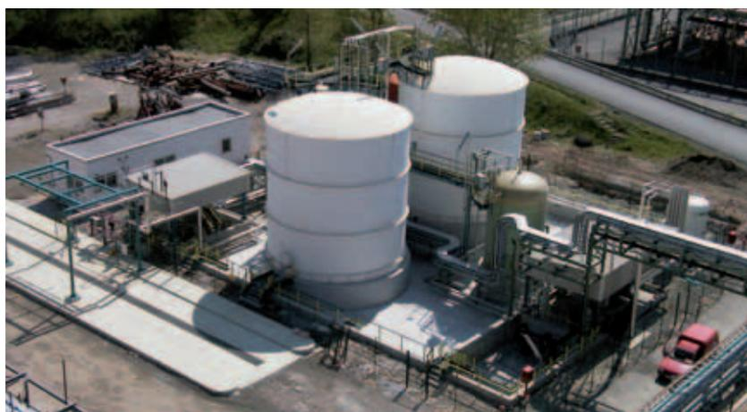
Tutti i serbatoi di stoccaggio di sostanze liquide sono disposti entro bacini o vasche di contenimento, i cui sistemi di drenaggio convogliano eventuali perdite e le acque meteoriche di dilavamento verso l'impianto di trattamento delle acque reflue. Eventuali perdite non hanno quindi alcun effetto ambientale interno e tanto meno esterno. Le sostanze polverulente sono contenute entro silos dotati di sistemi filtranti, capaci di trattenere emissioni significative di polveri.
