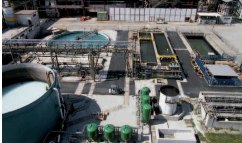
i fanghi che si formano dalle reazioni e i solidi sospesi sono fatti sedimentare in apposite sezioni di chiarificazione, e infine, prima dello scarico, con la neutralizzazione delle acque (correzione del pH).
