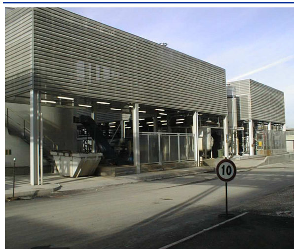
Foto 2 – Impianto Trattamento Acque Reflue
