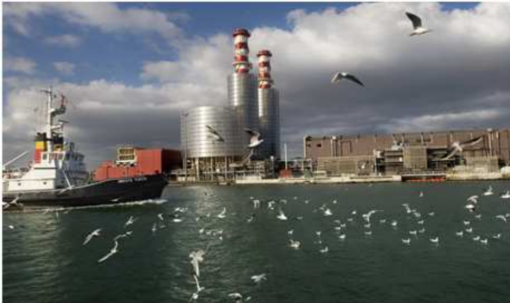
Foto 3 – Panoramica della centrale Teodora
