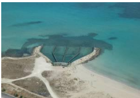
Figura 14 - Scarico acque di raffreddamento
