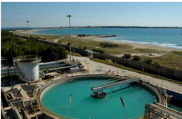
Figura 2 - Impianto integrato di trattamento delle acque
