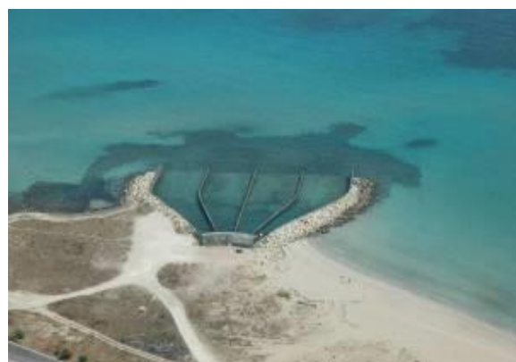
Figura 11 - Scarico acque di raffreddamento
