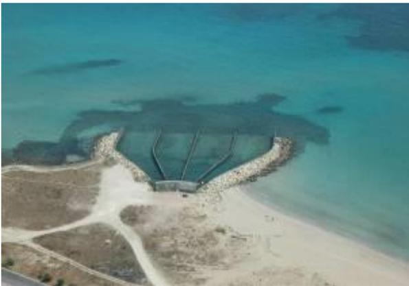
Figura 13 – Scarico acque di raffreddamento
