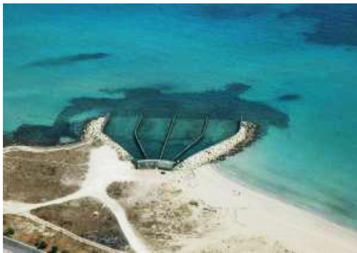
Figura 8 - Scarico acque di raffreddamento
