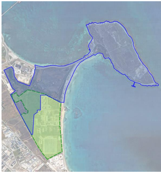
Figura 2 - Centrale Archimede di Priolo Gargallo (SR) ed ambiente circostante
