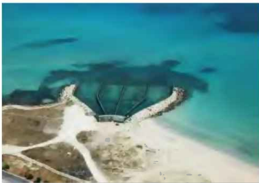
Figura 8 - Scarico acque di raffreddamento
