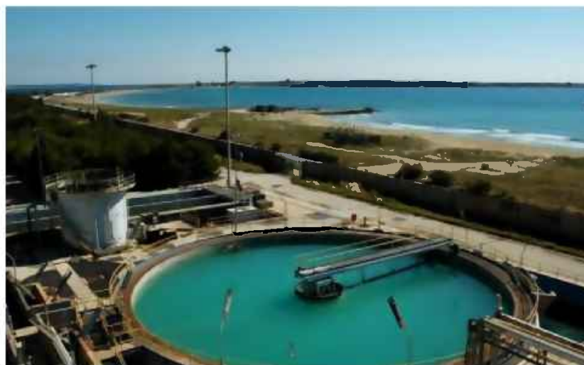
Figura 9 - Impianto integrato di trattamento delle acque
