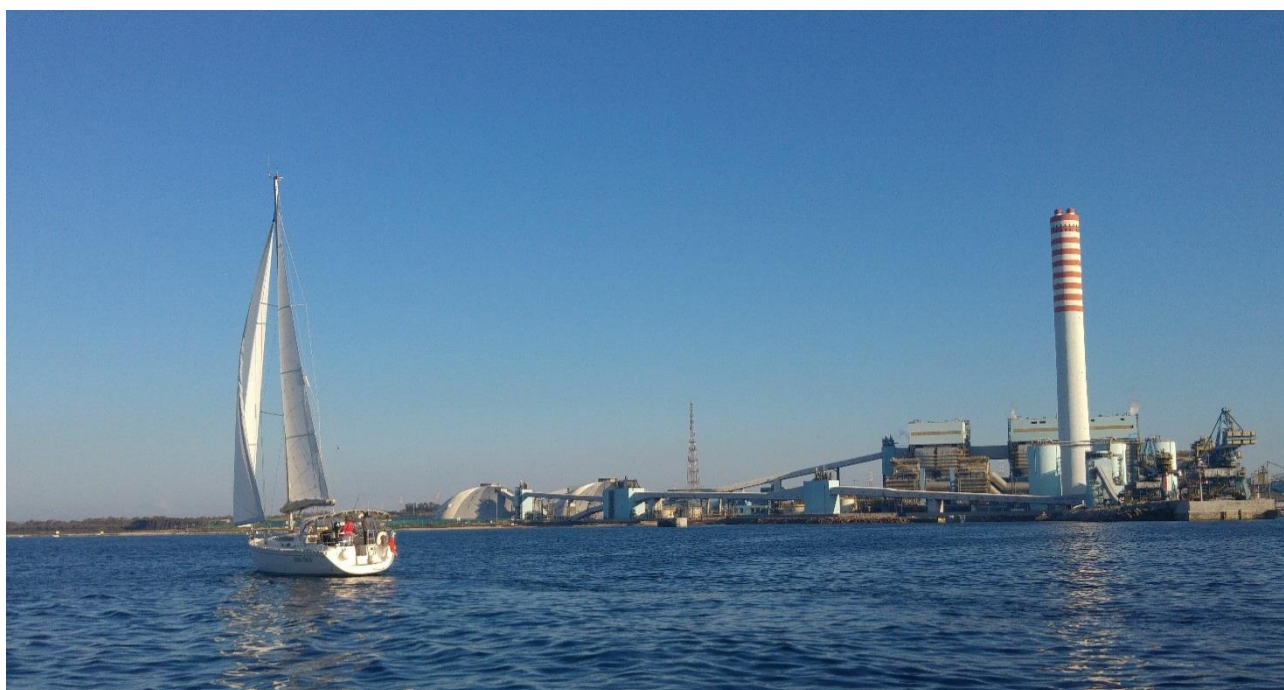
Vista panoramica del Power Plant Torrevaldaliga Nord
