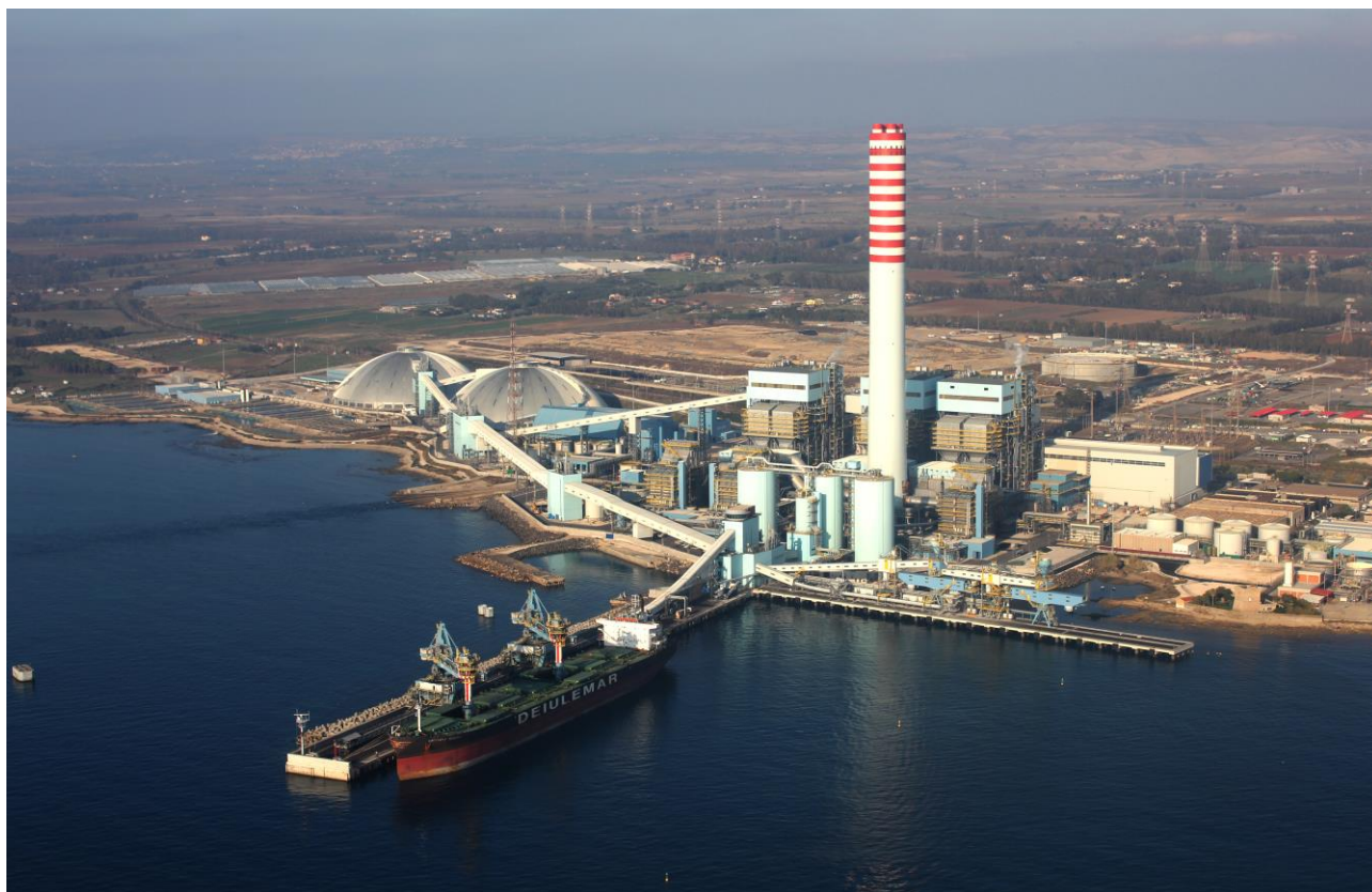
Vista panoramica del Power Plant Torrevaldaliga Nord
