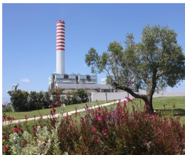
Vista panoramica del Power Plant
