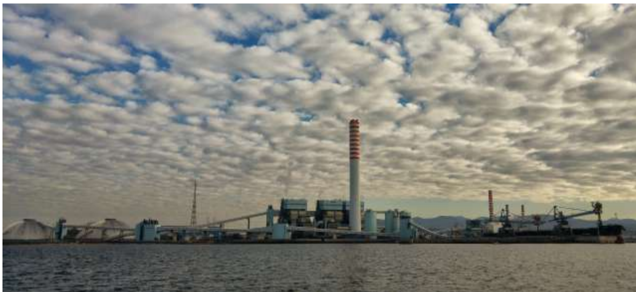
Figura 23 - Vista panoramica del Power Plant Torrevaldaliga Nord
