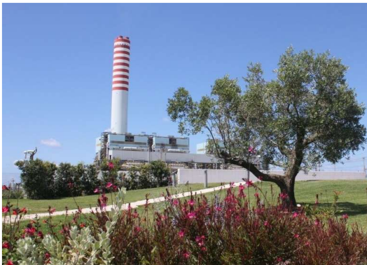
Figura 14 – Vista panoramica del Power Plant Torrealvaldliga Nord
