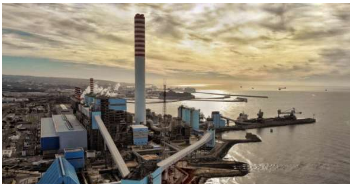
Figura 5 - Vista panoramica del Power Plant Torvaldaliga Nord
