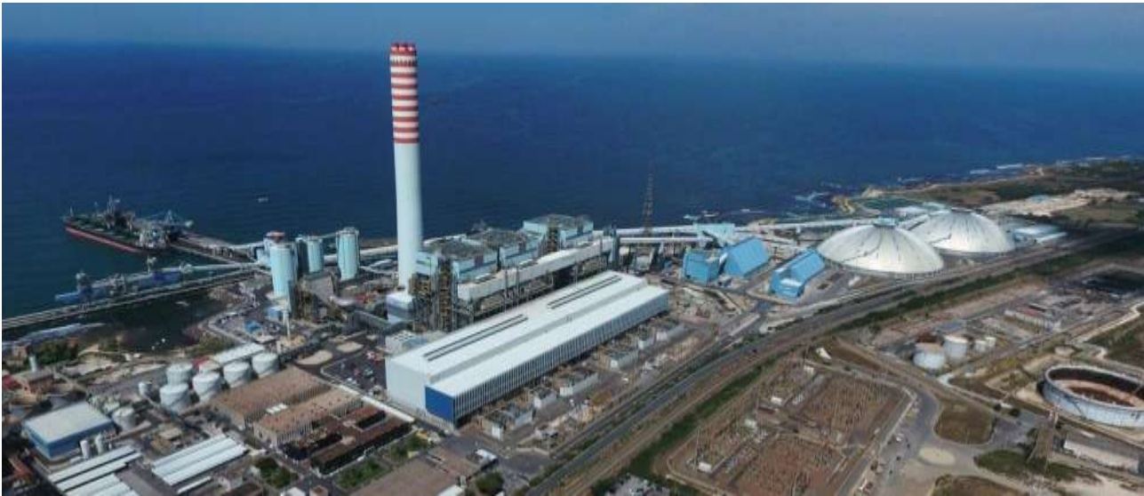
Figura 6 - Vista panoramica del Power Plant Torrevadalliga Nord
