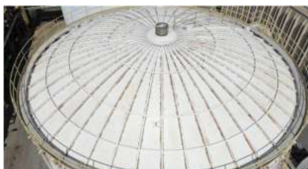
Figura 18 – Ispezione visiva per mezzo drone serbatoio acqua demineralizzata
