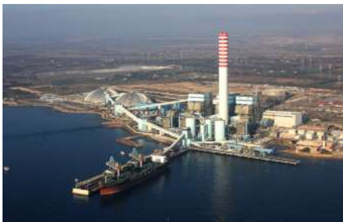
Figura 12 - Vista panoramica del Power Plant Torvaldaliga Nord
